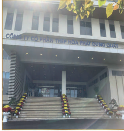
DỰ ÁN NHÀ MÁY THÉP HÒA PHÁT DUNG QUẤT
